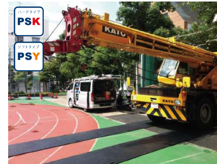
小学校耐震工事 (校庭養生)
