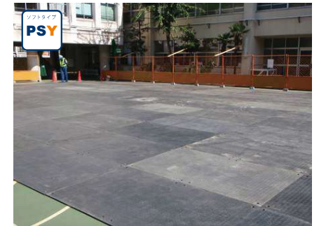
小学校耐震工事 (校庭養生)
