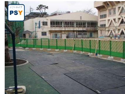
資材搬入路 (学校校庭タータン部養生)
